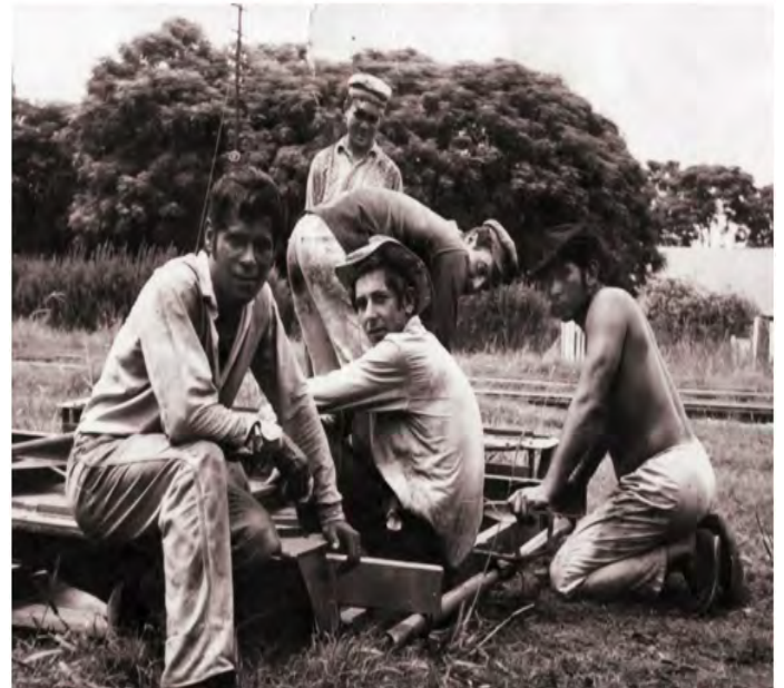
Trabajadores ferroviarios. Donación Hugo Iamónico
